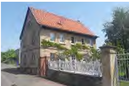
Historische Bausubstanz in der Friedhofstraße 5
