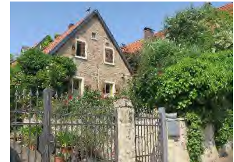
Historische Bausubstanz in der Weedegasse 16
