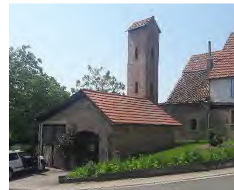
Ehemaliges Feuerwehrgerätehaus in der Hauptstraße
