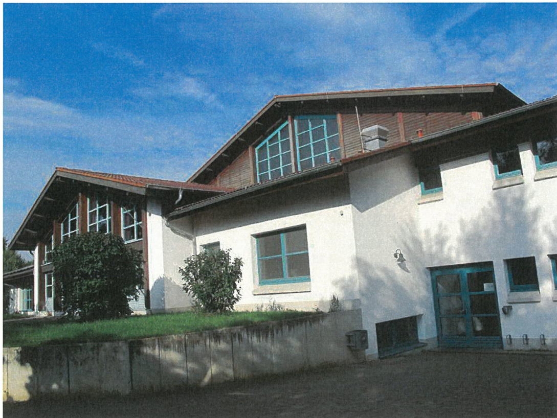
Petersberghalle Mühlstraße 32, 55239 Gau-Odernheim
